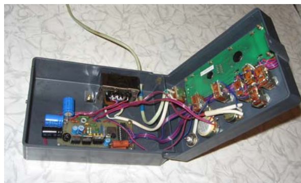
Рис. 3 Вид на монтаж генератора
