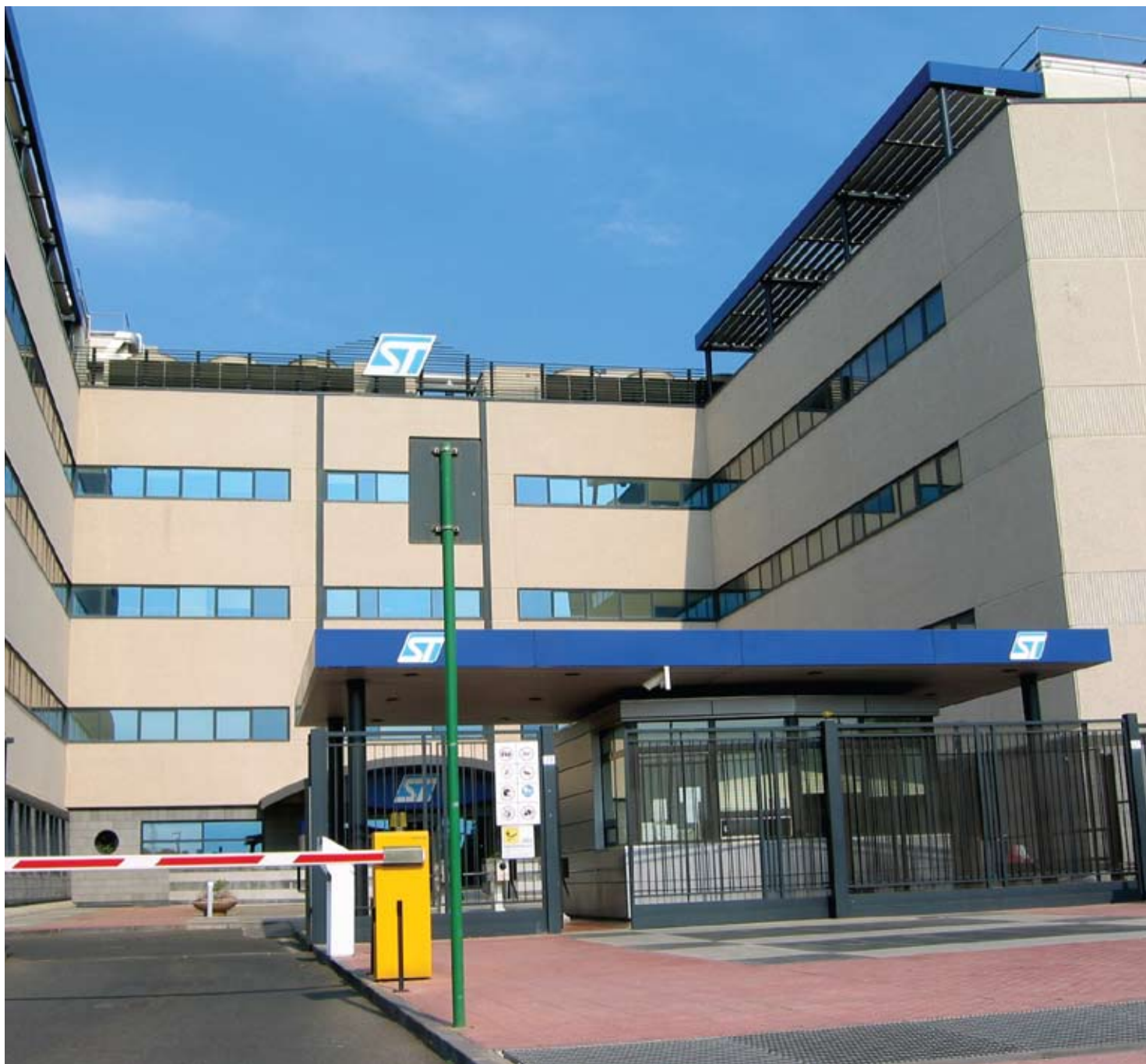
Производственный корпус STMicroelectronics в г. Катания, Сицилия
