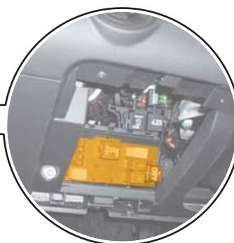
Блок реле на блоке управления бортовой сетью, под панелью приборов слева
