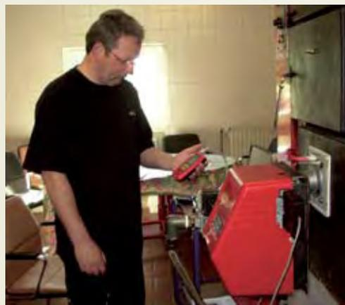
Рис.3 Монтаж и наладка параметров горелки
