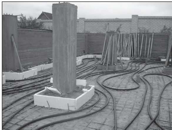
Рисунок 2. Монтаж системи горизонтальних теплообмінників
