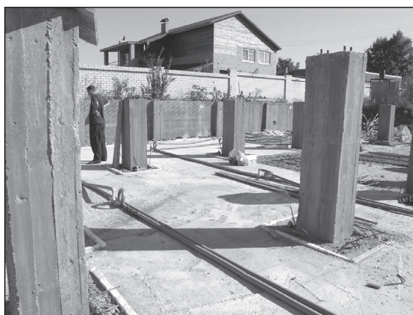
Рисунок 3. Інсталляція вертикальних теплообмінників
