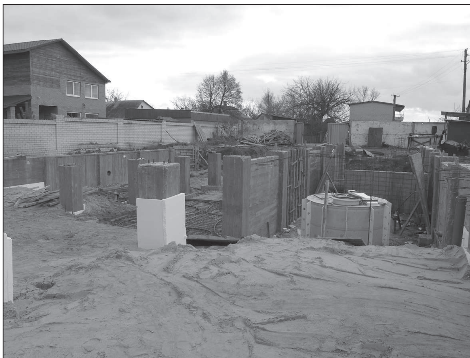
Рисунок 4. Засыпка верхней зоны сезонного аккумулятора тепла
