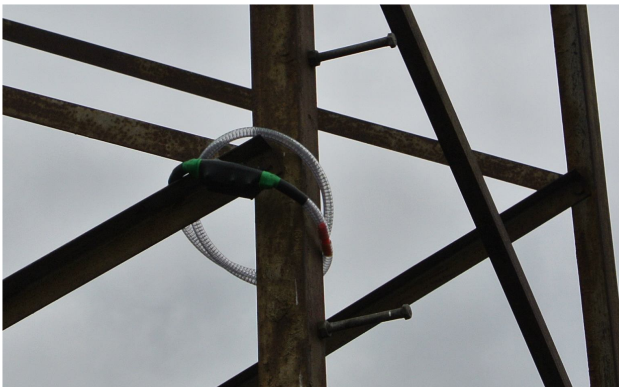
Рисунок 1. Пример установки РМ-01 в узле металлической опоры ЛЭП
