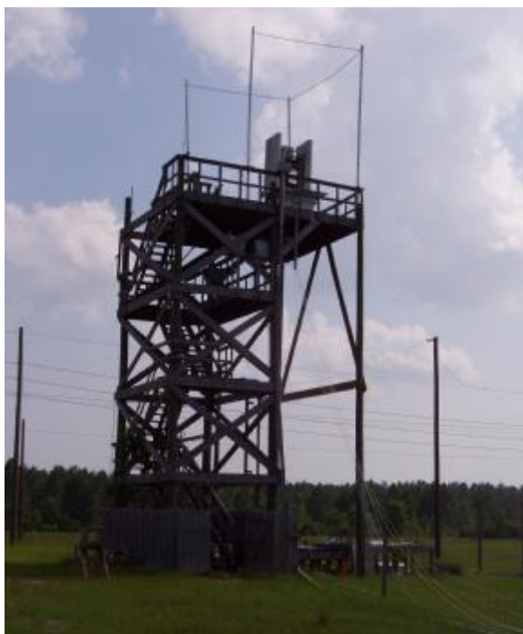
Рис.1.2. Стационарная 12-ти канальная пусковая установка в виде башни (высота верхней площадки башни над землёй составляет 11м)
